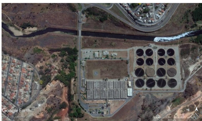
Figura 3. Vista por satélite da ETE Onça, onde o experimento foi realizado, a partir do Google Earth.
